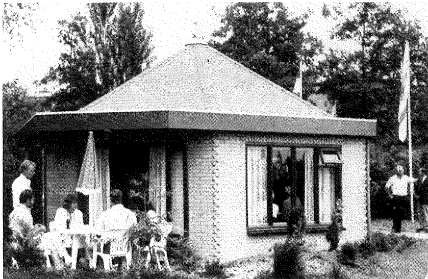
Gebouw Kogelgieterij. Moet verplaatst worden naar de Kerkpolder.
